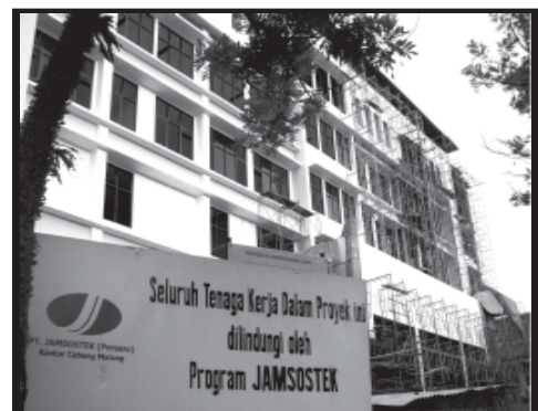
>>Fasilitas baru untuk meningkatkan mutu atau uang gedung?
